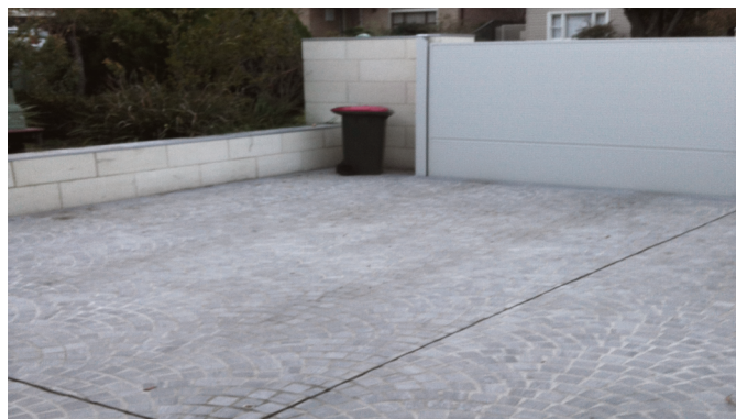
Покрытие из искусственного камня (толщиной 3 см)
