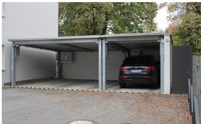
Парковочная система с перемещающимся навесом. Вид спереди.
