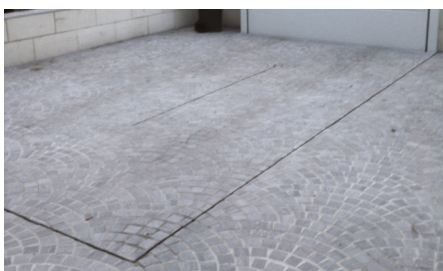
Покрытие из искусственного камня (толщиной 3 см)
