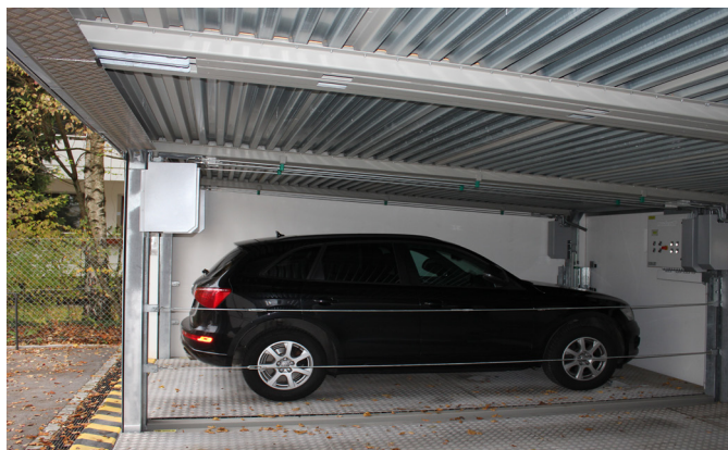
Парковочная система с перемещающимся навесом. Вид сбоку.
